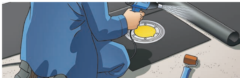
Fig. 3 – 21 Soldagem da tela de impermeabilização de EPDM com ar quente
