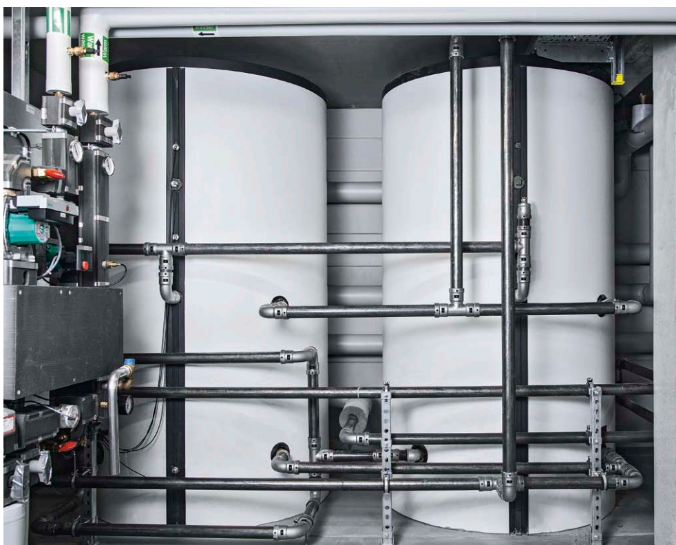
Megapress num sistema de aquecimento com termoacumuladores.
